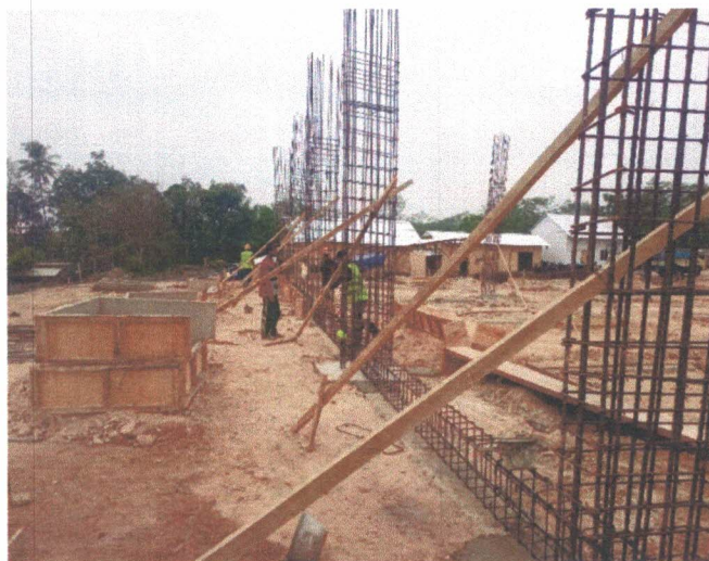
Pembesian Tie Beam
