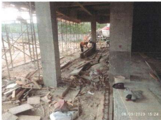
Pekerjaan Bekisting Sloof Teras
