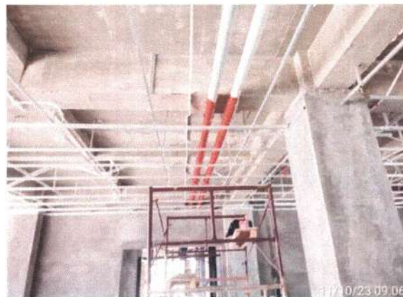
Pekerjaan Plumbing Lantai 1
