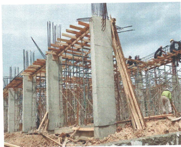
Pengecoran Kolom K4 35 x 80
