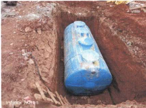
Pemasangan Bio Tank
