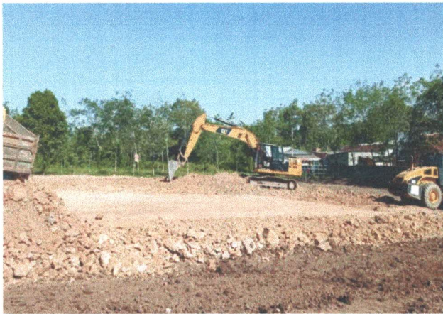
Pek. Timbunan Tanah Perataan Konstruksi
