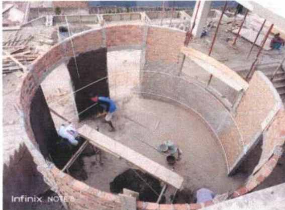
Pekerjaan Plester Dinding Tenan Lantai 2
