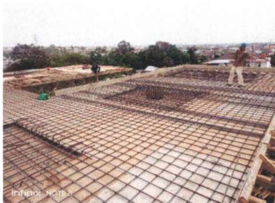
Pekerjaan Pembesian Plat Atap 1 dan Drop Panel
