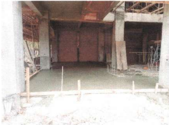
Pengecoran Plat Lantai 1
