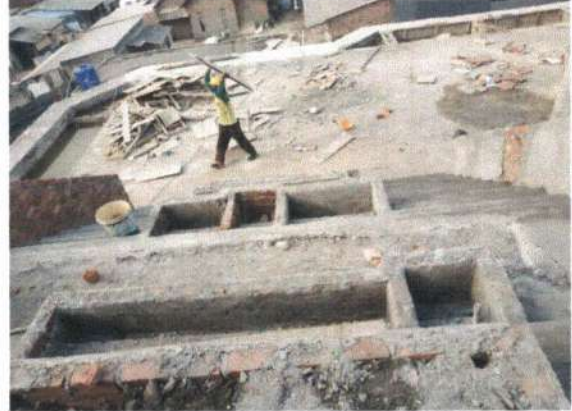
Pekerjaan Pot Tangga Lantai 3
