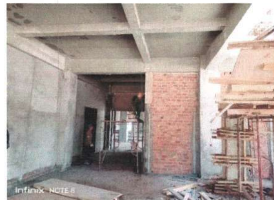
Pekerjaan Kolom Praktis Lantai 1
