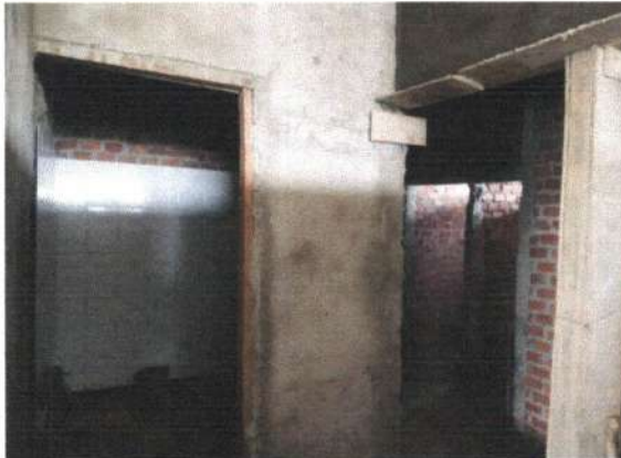
Pekerjaan Pemasangan Kramik Dinding Kamar Mandi Lantai 2
