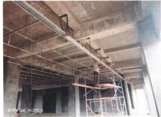
Pekerjaan Perkuatan Pintu PJ1
