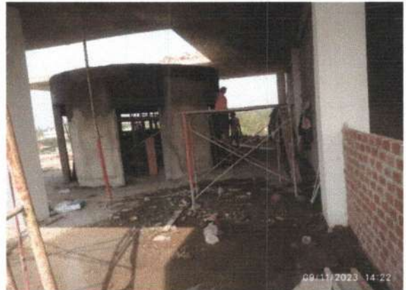
Pekerjaan Plester Dinding Tenan Lantai 3
