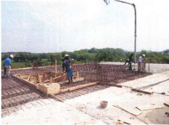
Pengecoran Plat Lantai 3
