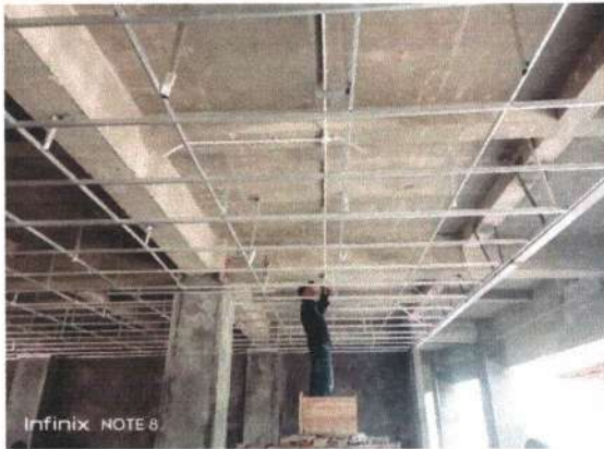
Pekerjaan Rangka Plafon Lantai 1
