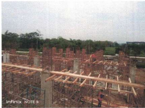
Pekerjaan Bekisting Balok Lantai 3
