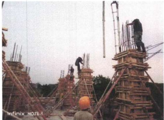
Pengecoran Kolom Lantai 2
