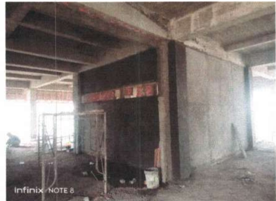
Pekerjaan Balok Latei Lantai 1
