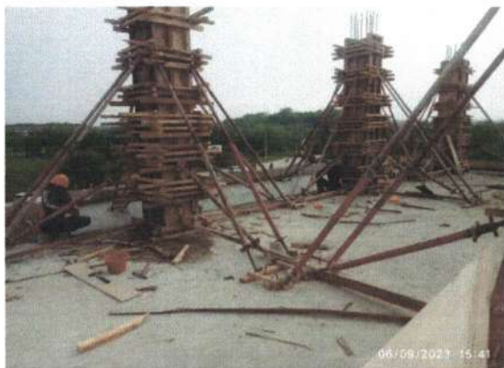
Pekerjaan Bekisting Kolom Struktur Lantai 3
