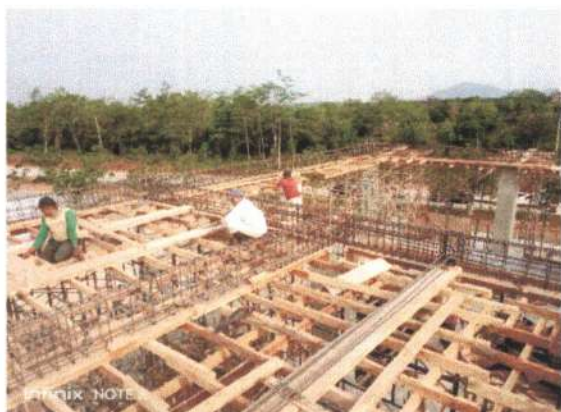
Pekerjaan Pembesian Balok Atap
