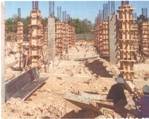
Bekisting Kolom K1 50 X 50
