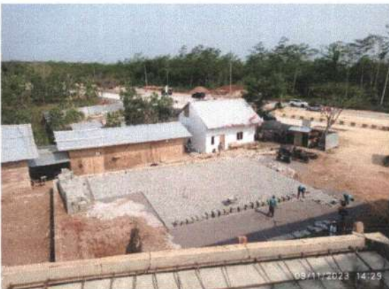
Pekerjaan Pemasangan Grass Block Area Parkiran
