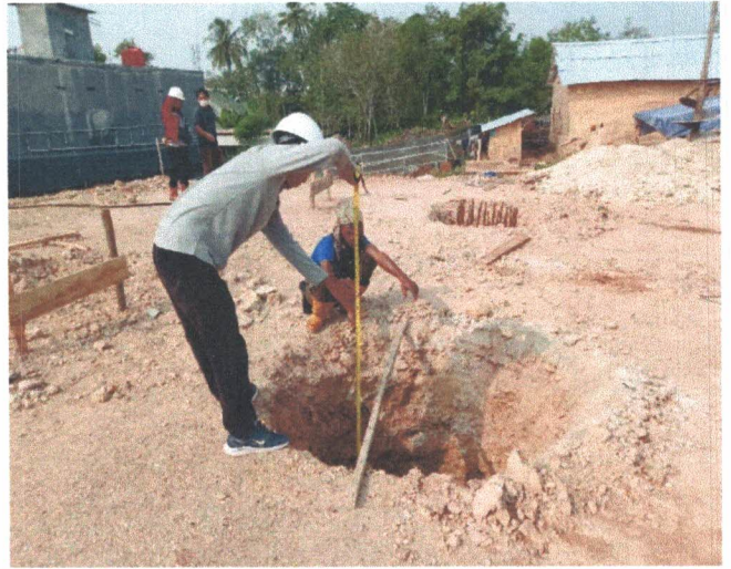
Pengeboran Pondasi Bore Pile
