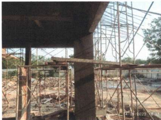
Pekerjaan Finishing Kolom Struktur
