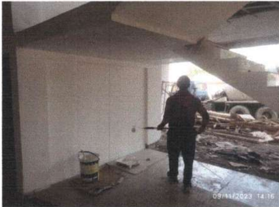
Pekerjaan Pengecatan Dinding Lantai 1
