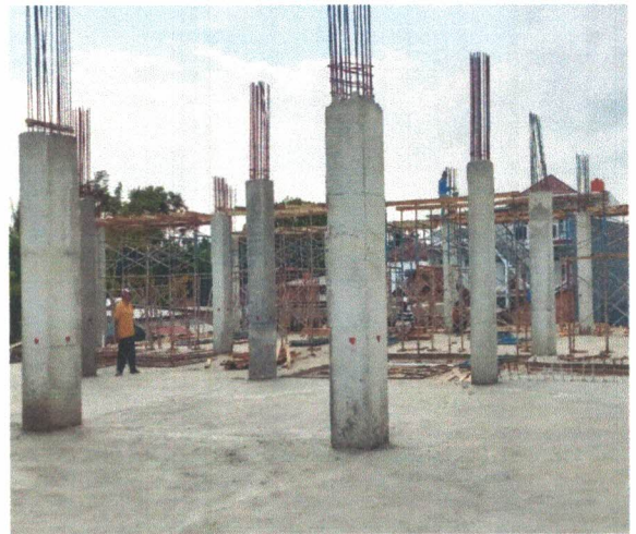
Pengecoran Kolom K1 50 X 50
