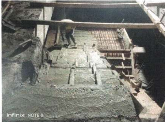
Pengecoran Tangga T1 Lantai2
