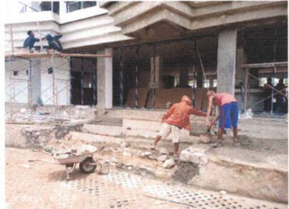
Pekerjaan Tangga Teras
