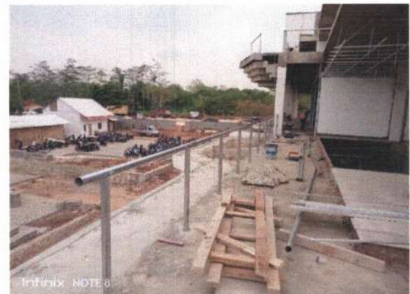
Pekerjaan Pemasangan Railing
