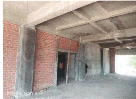
Pekerjaan Balok Latei Lantai 1
