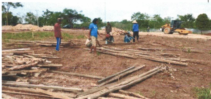
Pembuatan Barak Kerja
