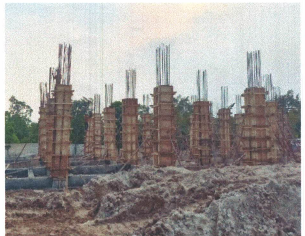
Bekisting Kolom K2 40 X 40
