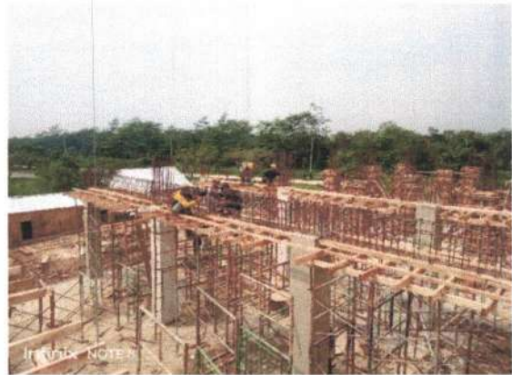
Pekerjaan Pembesian Balok Lantai 3
