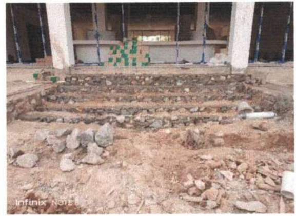
Pekerjaan Tangga Teras
