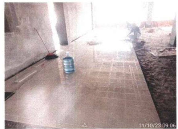
Pekerjaan Pemasangan Granit Lantai 1
