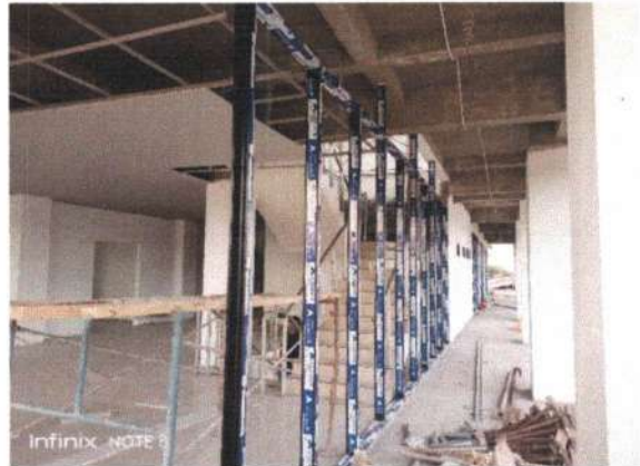
Pekerjaan Pemasangan Kusen Lantai 2
