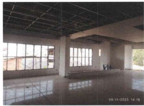
Pekerjaan Pemasangan Kusen Kaca Lantai 1
