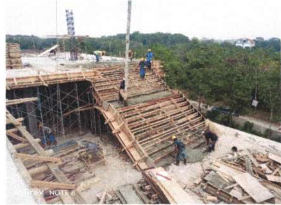
Pengecoran Tangga Tipe T3 Lantai 2
