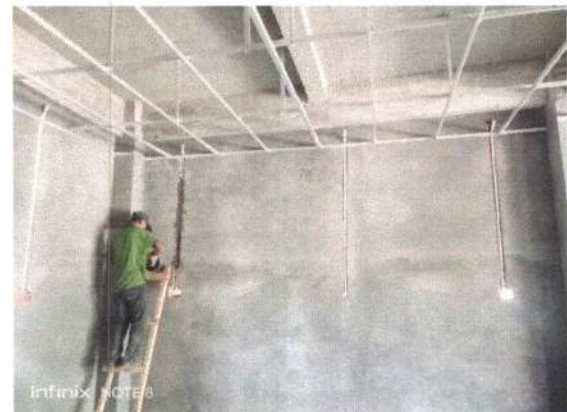
Pekerjaan Instalasi Listrik Lantai 1
