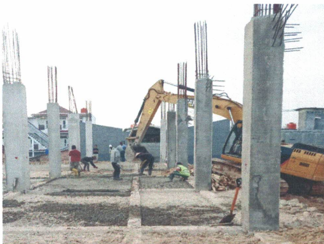
Pengecoran Kolom K2 40 X 40
