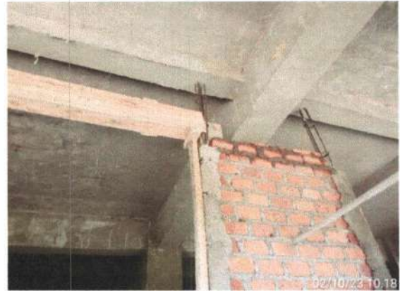
Pekerjaan Balok Latei Lantai 2
