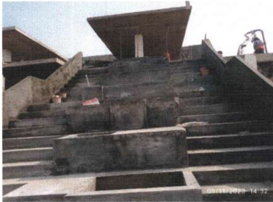
Pekerjaan Plester Tangga dan Pot Tangga Lantai 3
