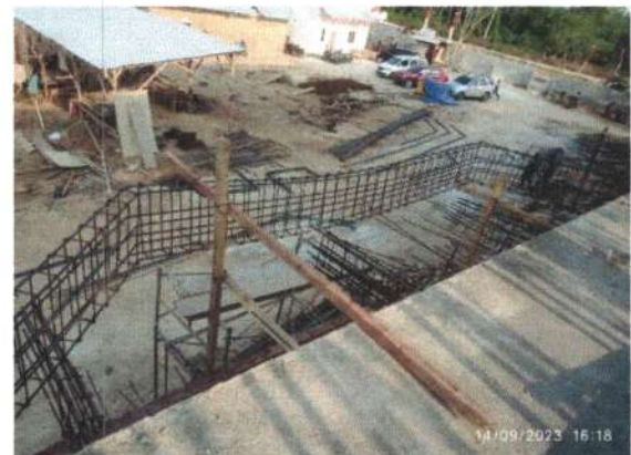
Pekerjaan Pembesian Balok B4 Lantai 2
