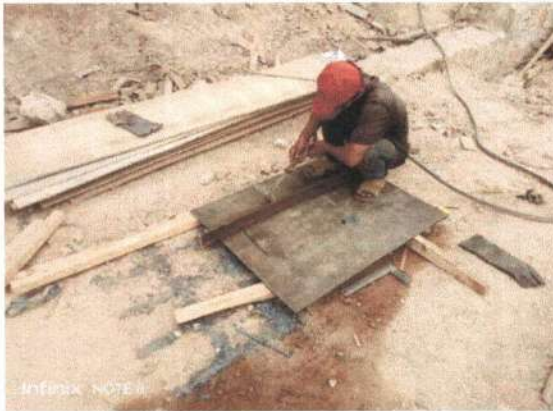
Fabrikasi Baseplate Atap Baja
