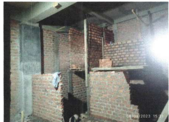
Pekerjaan Dinding Pasangan Bata Lantai 1
