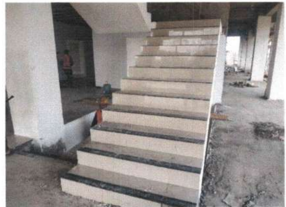
Pekerjaan Pemasangan Granit Tangga Lantai 2
