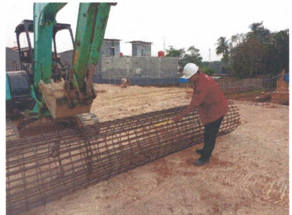
Pembesian Bore Pile
