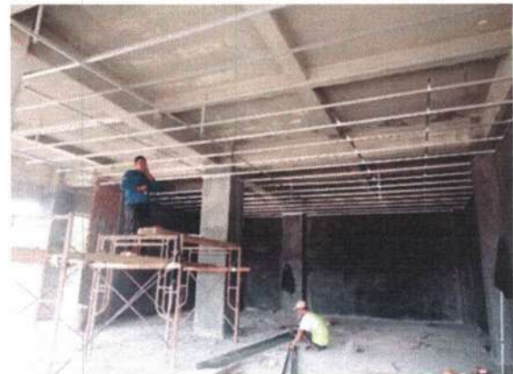
Pekerjaan Rangka Plafon Lantai 1
