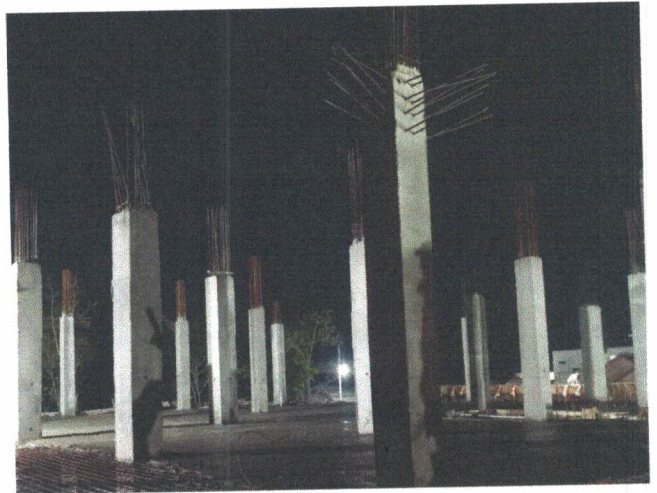
Pengecoran Kolom K3 40 x 50
