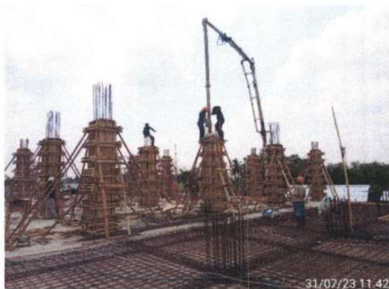
Pengecoran Kolom Lantai 2
