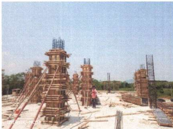
Pekerjaan Pembesian dan Bekisting Kolom Lantai 3
