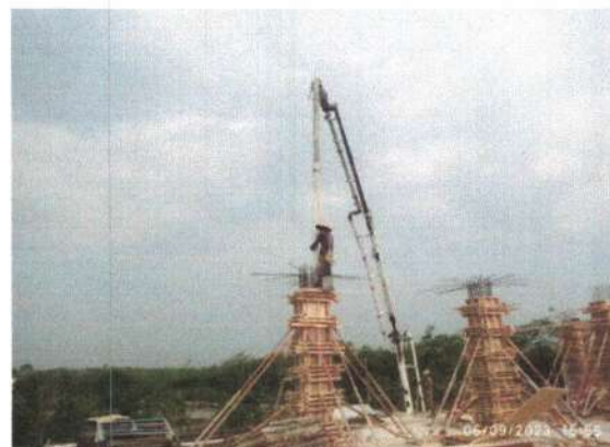
Pengecoran Kolom Struktur Lantai 3
