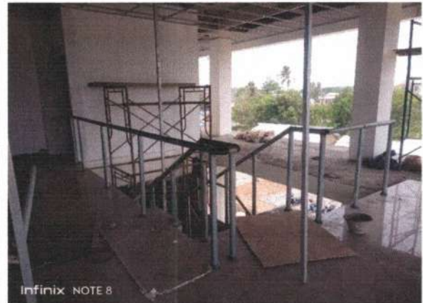
Pekerjaan Pemasangan Railing Tangga
