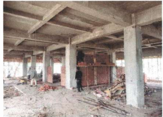
Pekerjaan Dinding Pasangan Bata Lantai 1
