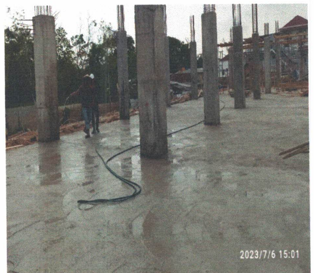
Pengecoran Pelat Lantai 1
