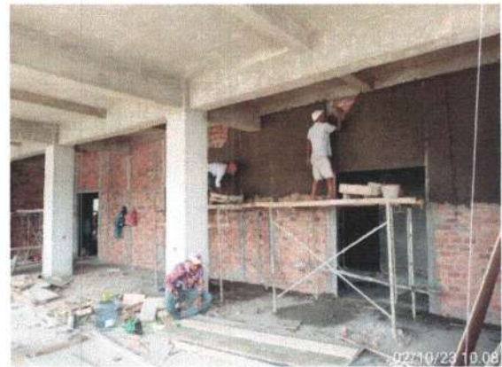
Pekerjaan Plaster Dinding Lantai 2
