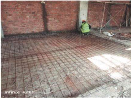
Pekerjaan Pembesian Plat Lantai 1
