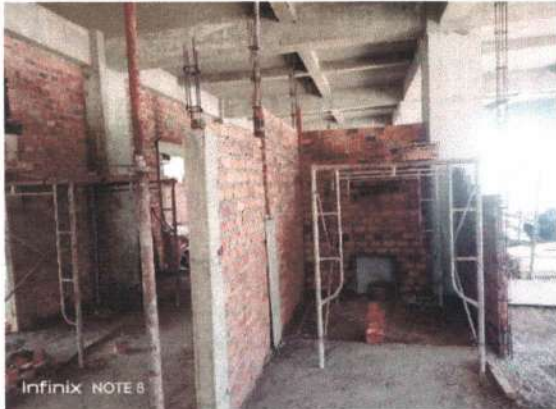
Pekerjaan Dinding Pasangan Bata Lantai 2
