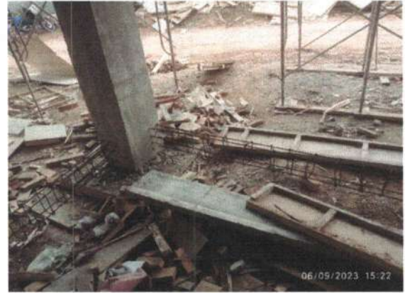
Pekerjaan Pembesian Sloof Teras
