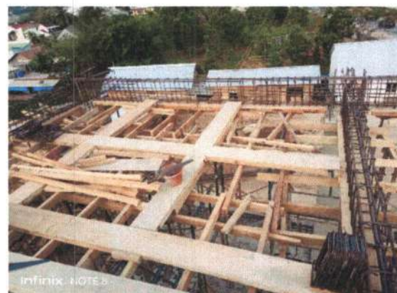
Pekerjaan Bekisting Balok Atap
