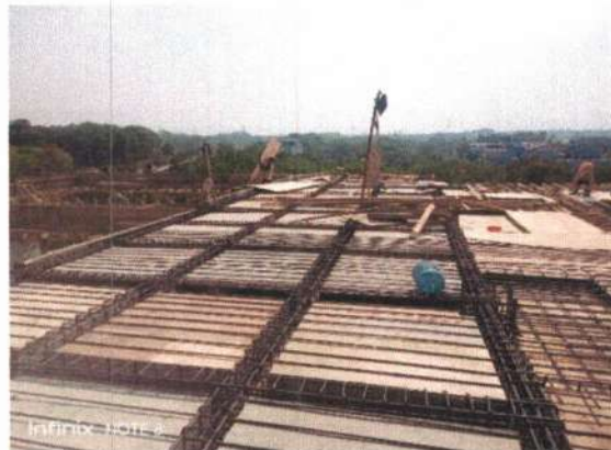
Pekerjaan Pembesia Balok Atap
