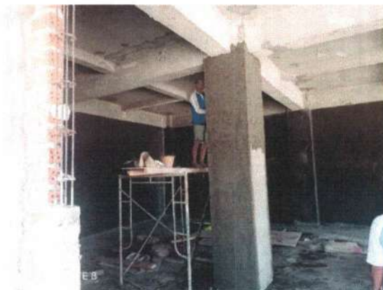
Pekerjaan Finishing Kolom Struktur Lantai 1
