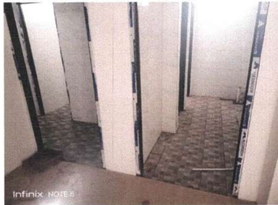
Pekerjaan Pemasangan Kusen Kamar Mandi Lantai 2
