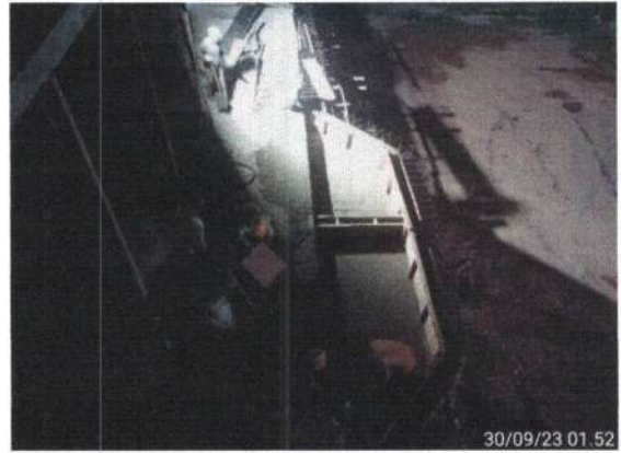
Pengecoran Plat Vegetasi Lantai 2
