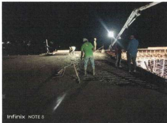
Pengecoran Plat Lantai Atap
