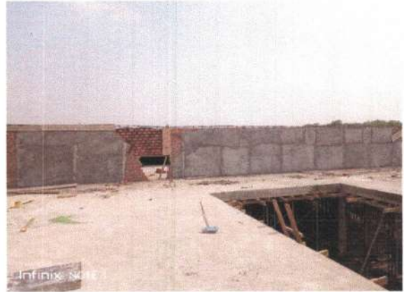
Pekerjaan Plester Dinding Papet
