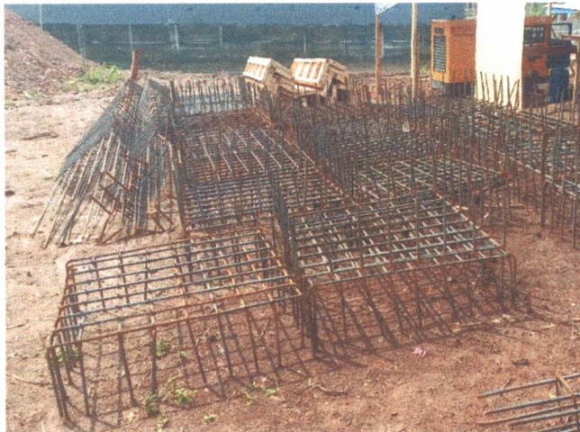
Pembesian Pile Cap
