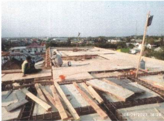
Pekerjaan Bekisting Plat Atap 1
