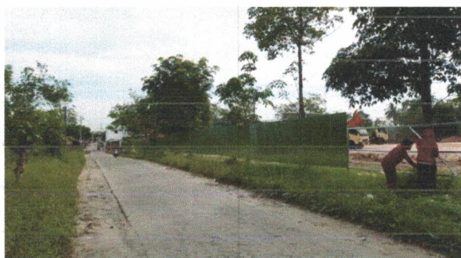
Pembuatan Pagar Proyek
