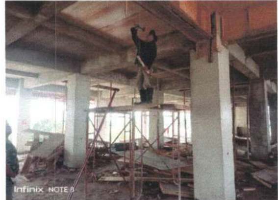
Pelepasan Bekisting Plat Lantai 3
