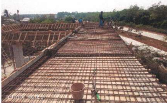
Pekerjaan Pembesian Plat Atap
