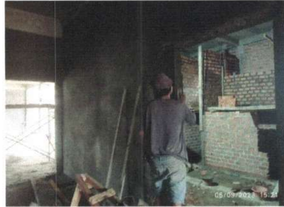
Pekerjaan Openingan Kusen Lantai 1
