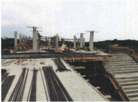
Fabrikasi Pembesian Plat Lantai Atap
