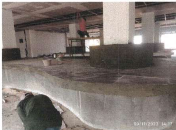
Pekerjaan Instalasi Listrik Lantai 1
