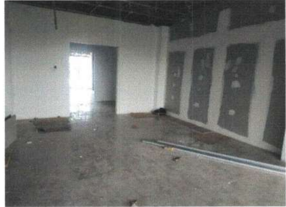
Pekerjaan Pemasangan Dinding Partisi Lantai 2
