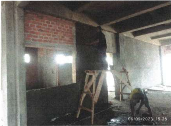
Pekerjaan Plaster Dinding Lantai 1
