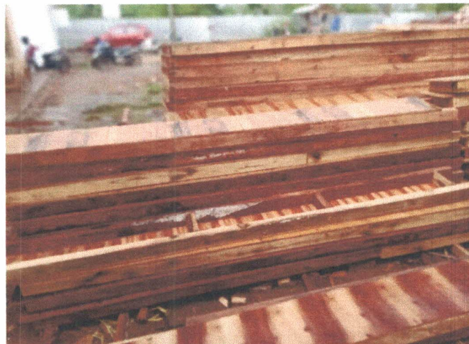
Bekisting Balok B5
