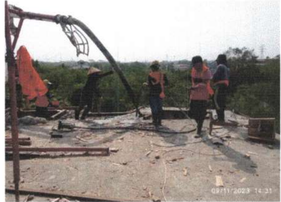
Pengecoran Fasat Lantai 3
