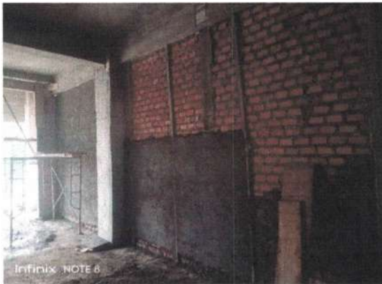
Pekerjaan Plasteran Dinding Lantai 1
