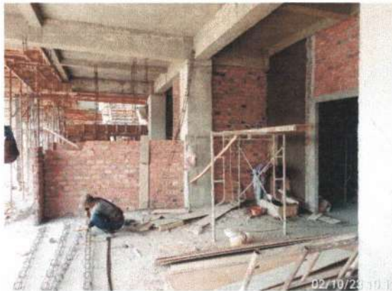
Pekerjaan Kolom Praktis Lantai 2
