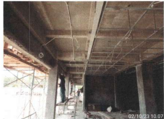
Pekerjaan Instalasi Listrik Lantai 1
