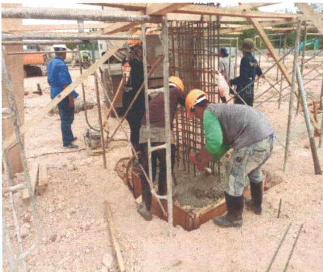
Pengecoran Pile Cap
