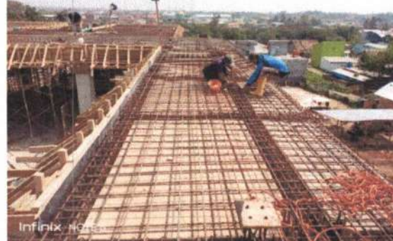
Pekerjaan Angkur Atap
