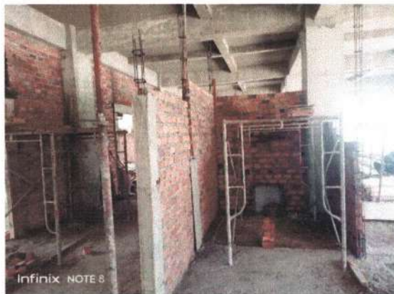
Pekerjaan Kolom Praktis Lantai 2
