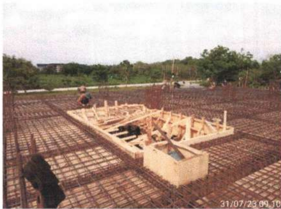
Pekerjaan Pembesian Plat Lantai 2
