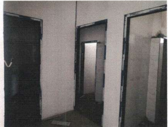
Pekerjaan Pemasangan Kusen Kamar Mandi Lantai 2
