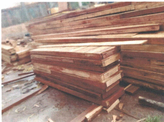
Bekisting Balok A2
