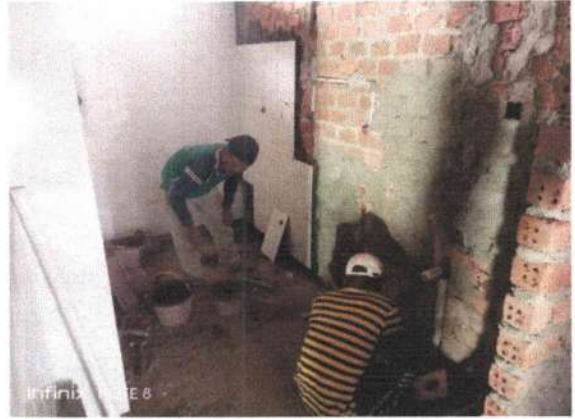
Pekerjaan Pemasangan Keramik Kamar Mandi
