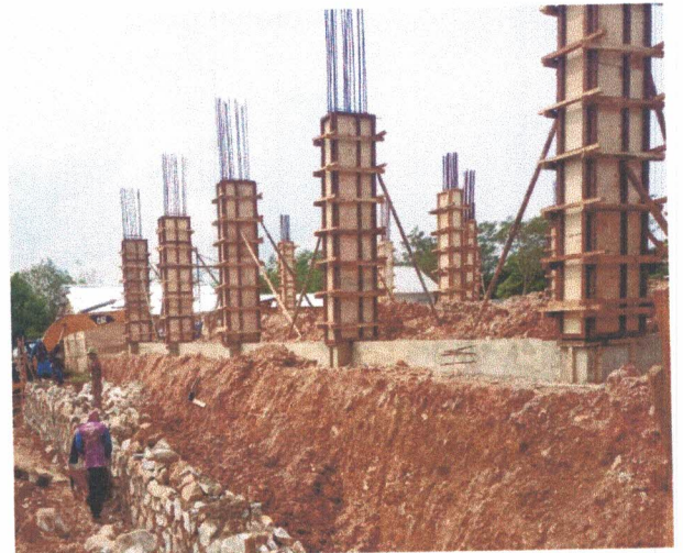
Bekisting Kolom K4 35 x 80
