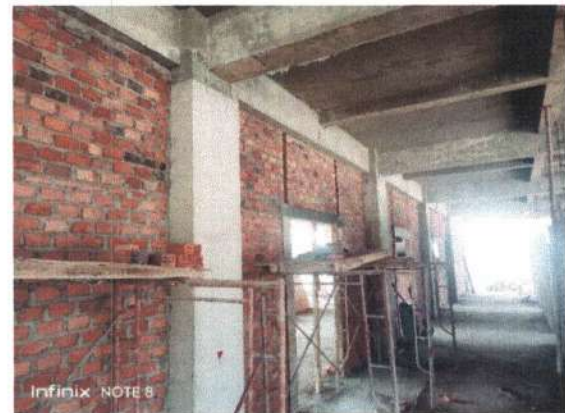
Pekerjaan Openingan Pintu Lantai 2
