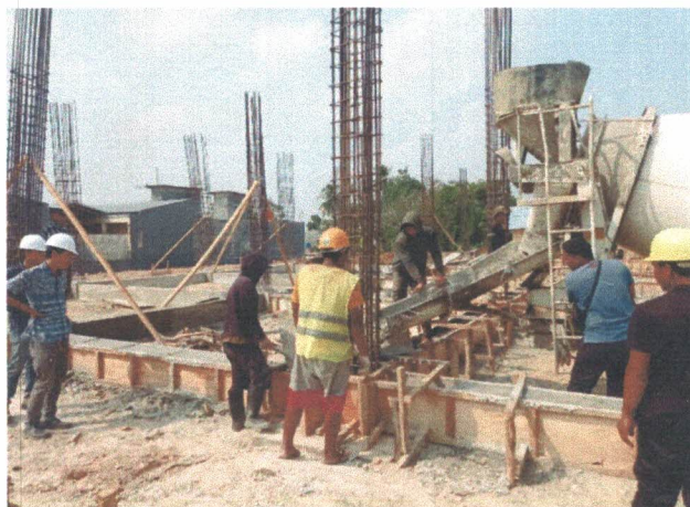
Pengecoran Tie Beam
