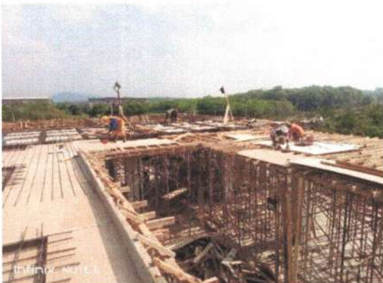
Pekerjaan Bekisting Plat Atap 1
