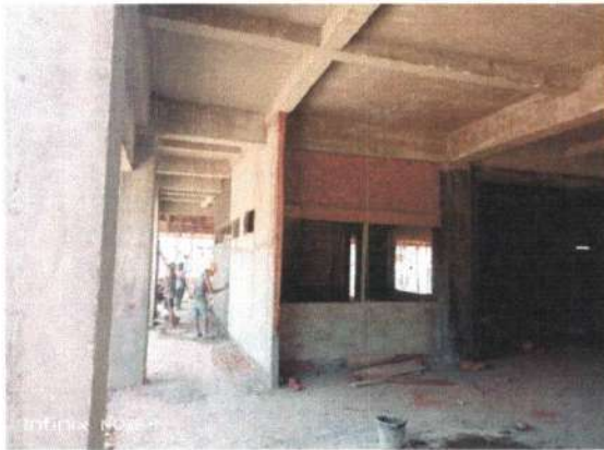
Pekerjaan Plaster Dinding Lantai 1
