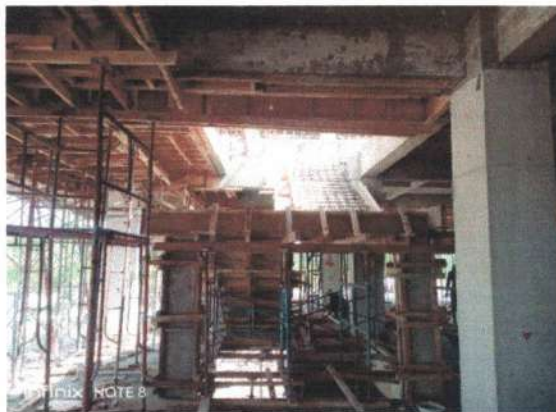
Pekerjaan Pembesian dan Bekisting Tangga T1 Lantai 2
