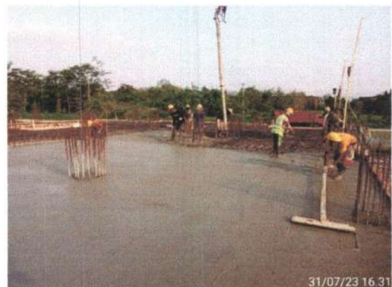
Pengecoran Plat Lantai 2
