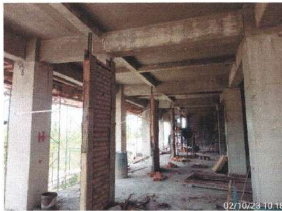
Pekerjaan Dinding Pasangan Bata Lantai 2
