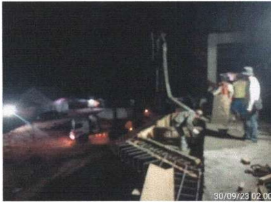
Pengecoran Balok B4 Lantai 2
