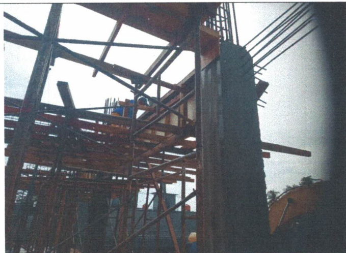
Bekisting Balok B2
