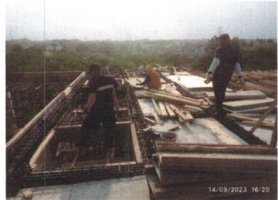
Pekerjaan Bekisting Balok dan Plat Atap
