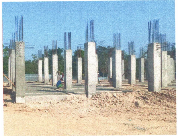
Pengecoran Kolom K6 60 x 60
