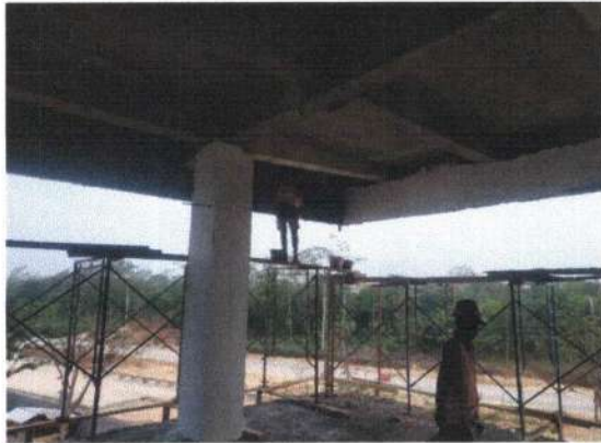
Pekerjaan Plester List Plank Lantai 3
