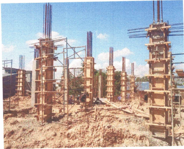
Bekisting Kolom K3 40 x 50
