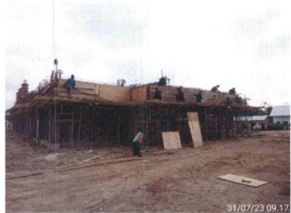
Pekerjaan Pembesian Balok B5 Lantai 2
