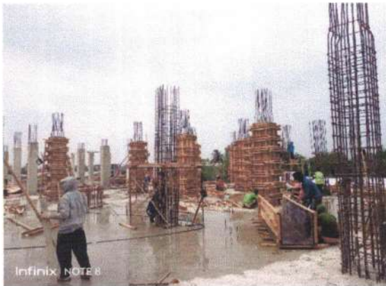
Pekerjaan Pembesian dan Bekisting Kolom Lantai 2
