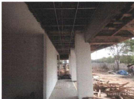
Pekerjaan Pengecatan Dinding Lantai 1
