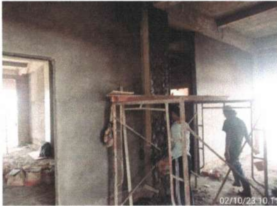
Pekerjaan Openingan Pintu Lantai 2
