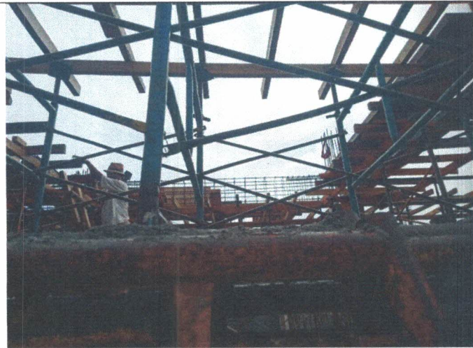
Bekisting Balok BT8
