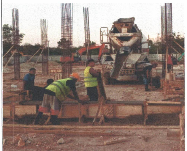
Pengecoran Sloof
