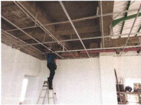
Pekerjaan Pipa Hindrant
