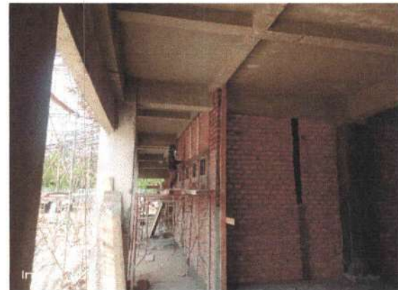
Pekerjaan Dinding Pasangan Bata Lantai 1
