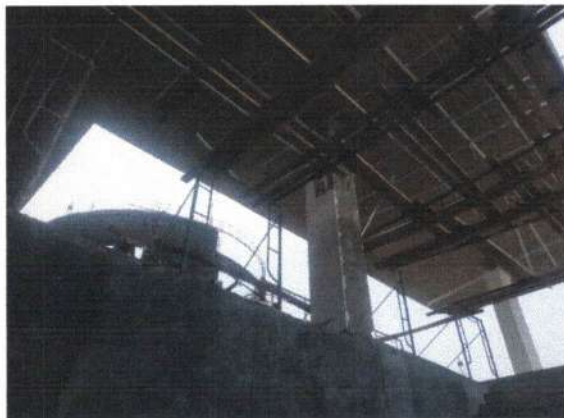
Pekerjaan Pemasangan Rangka Plafon Kanopi Lantai 2
