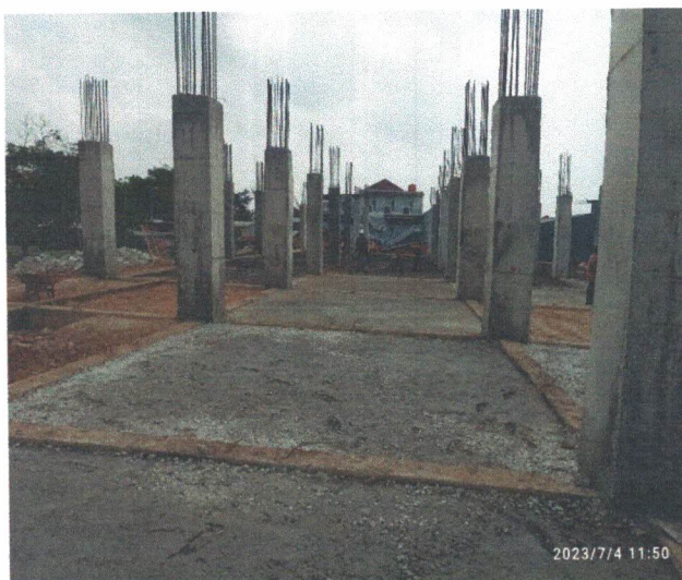
Lantai Kerja Pelat Lantai 1
