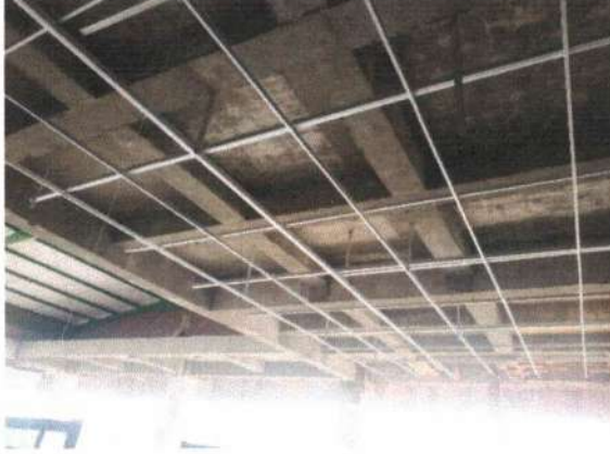
Pekerjaan Rangka Pafon Lantai 3
