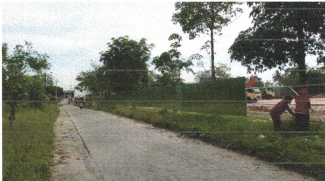
Pembuatan Pagar Proyek
