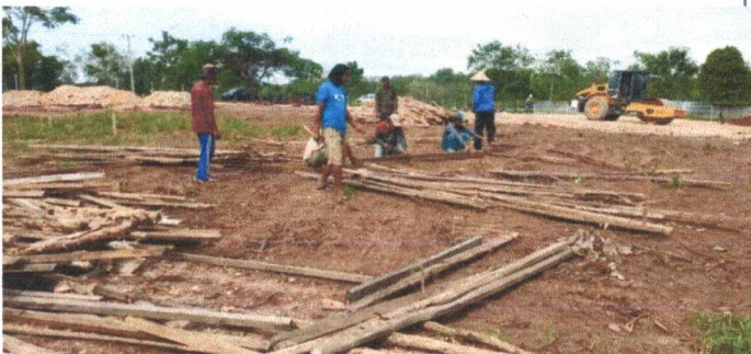
Pembuatan Barak Kerja
