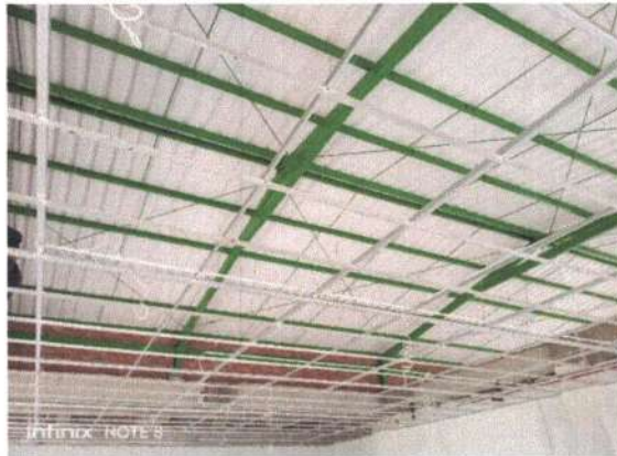
Pekerjaan Pemasangan Rangka Atap
