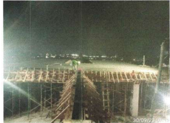
Pengecoran Balok Lantai Atap
