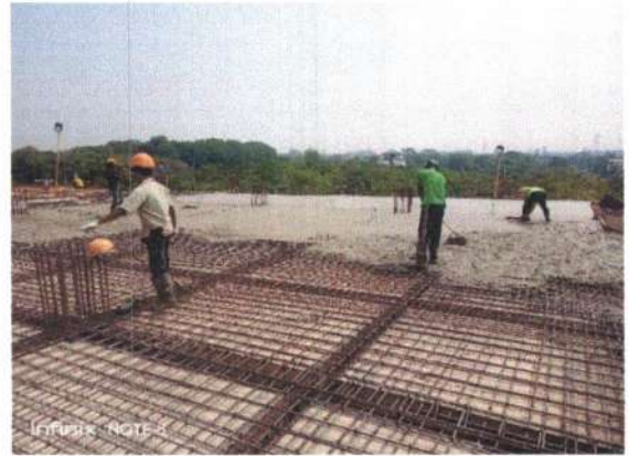
Pengecoran Plat Lantai 2
