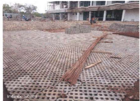
Pekerjaan Pemasangan Grass Block Area Parkir
