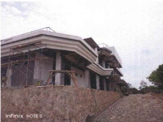
Pekerjaan Finishing List Plank
