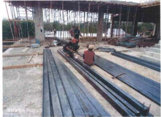
Fabrikasi Rangka Atap Baja
