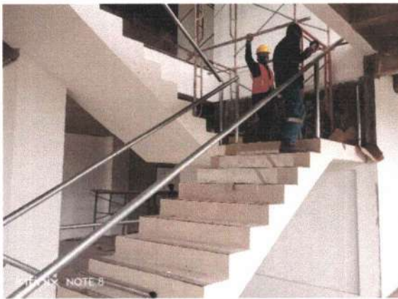
Pekerjaan Pemasangan Railing Tangga
